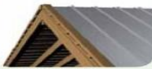
Abb. 23 Das Paneel wird zurechtgebogen, es werden die Montageöffnungen gebohrt.
