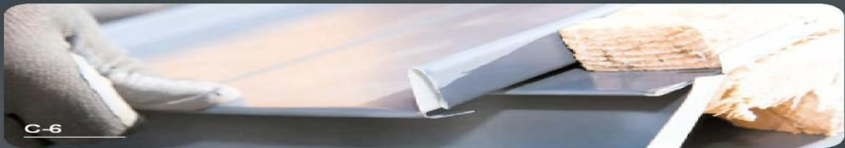
Die Erste Tafel wird parallel zur Giebelplatte verlegt.
