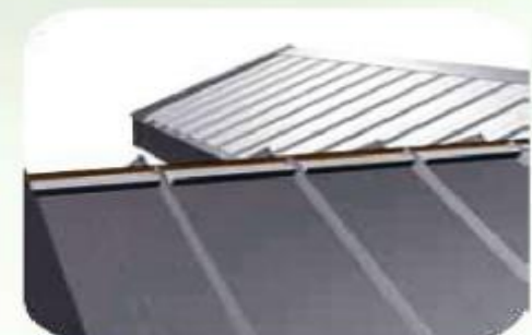
Abb. 28 Indirekt angefertigter Dachfirst
