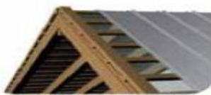
Abb. 21 Montage der Bretter an der Gebäudepitze
