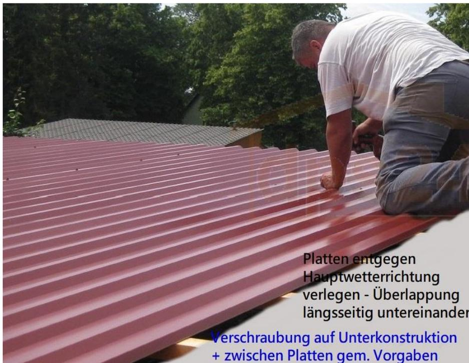
Verlegung Trapezblechplatten erfolgt gegen Hauptwindrichtung, also so, daß peitschendes Wasser auf die überlappende Seite trifft!
